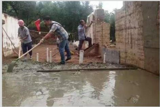
浇筑混凝土
