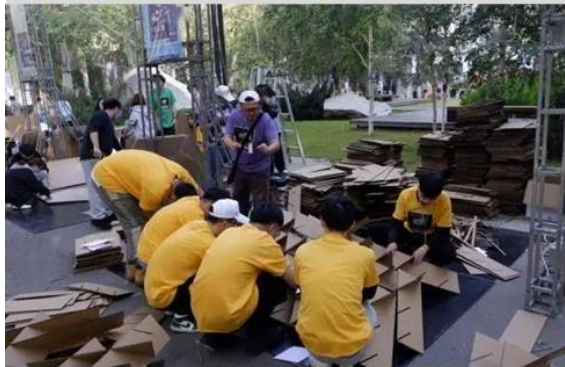
各参展团队正式开始现场构筑，53个代表队开始搭建
